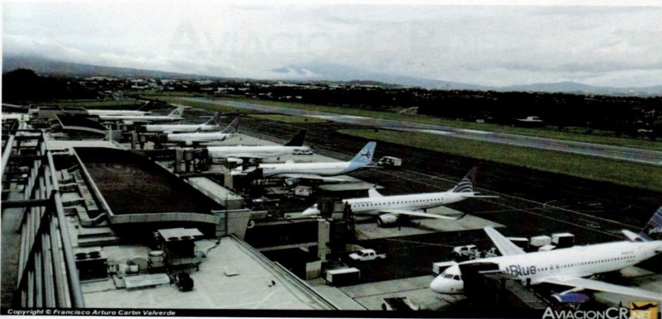
Aeropuerto Internacional Juan Santamaría, Nueva Terminal
