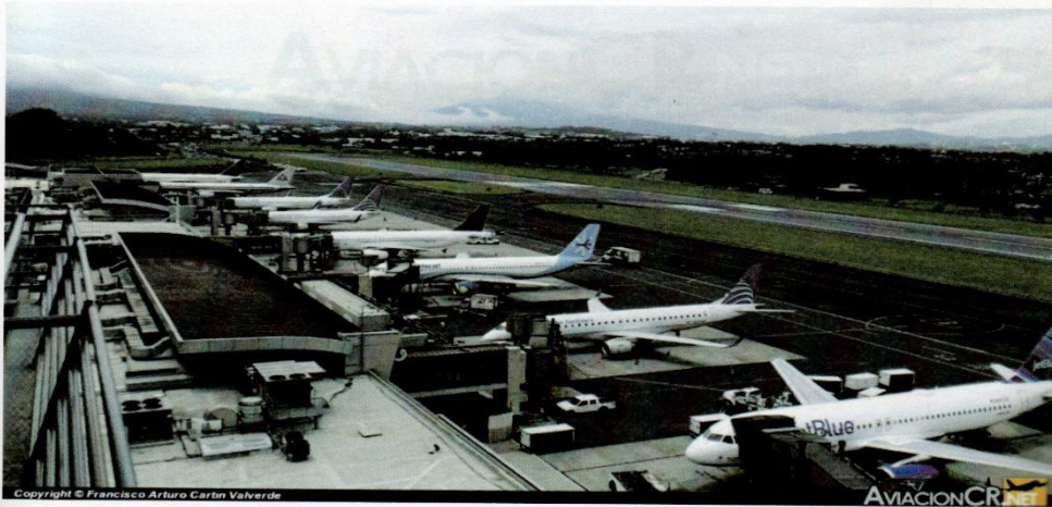
Aeropuerto Internacional Juan Santamaría, Nueva Terminal
